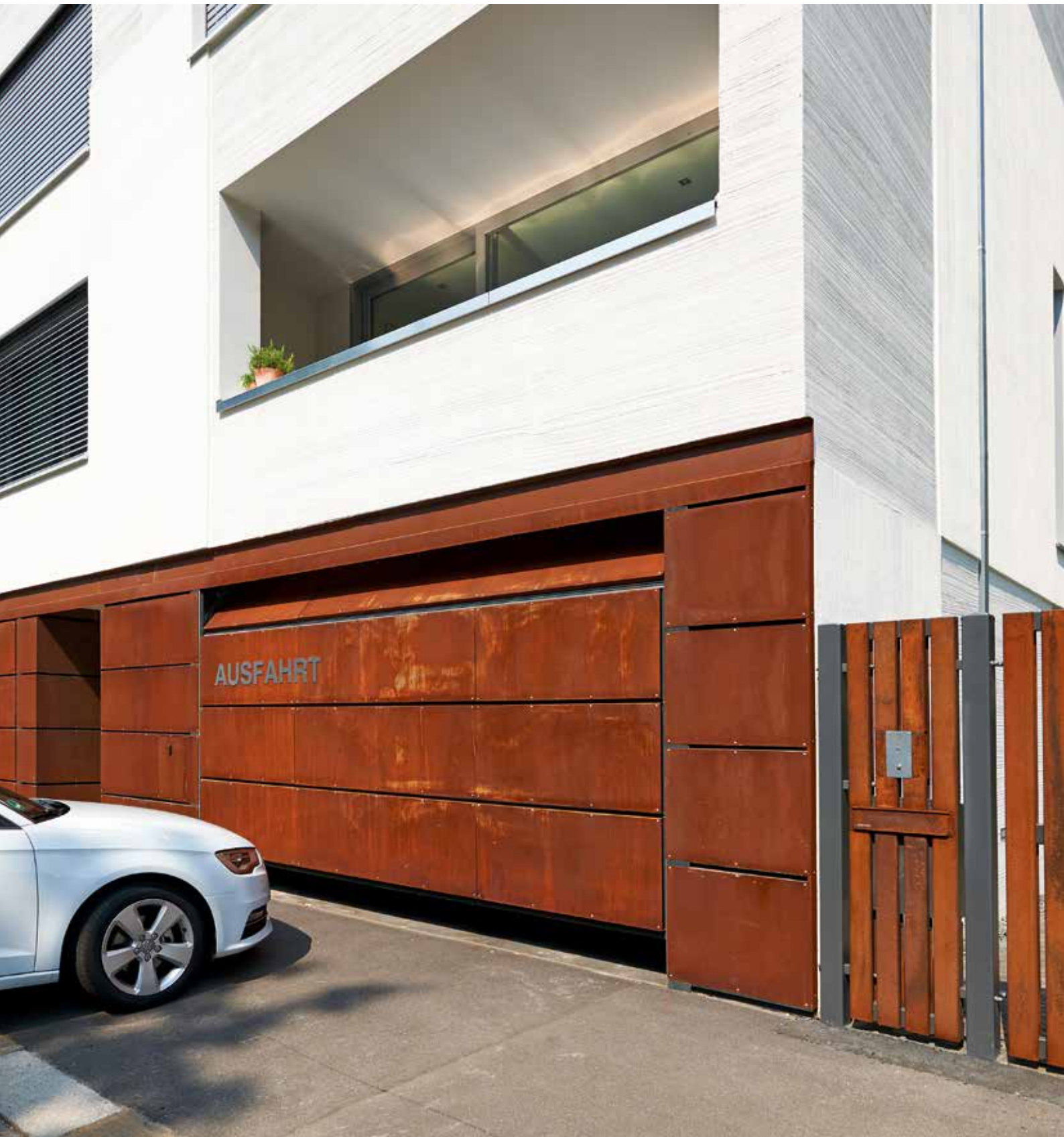
Облицовка ламинированными панелями, выполняемая заказчиком
